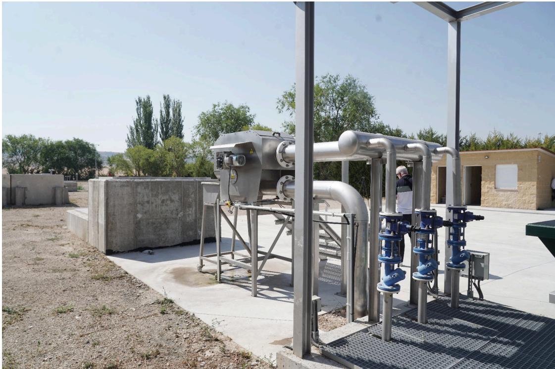
Estación depuradora de Castronuevo de Esgueva Rubén Cacho/Ical
