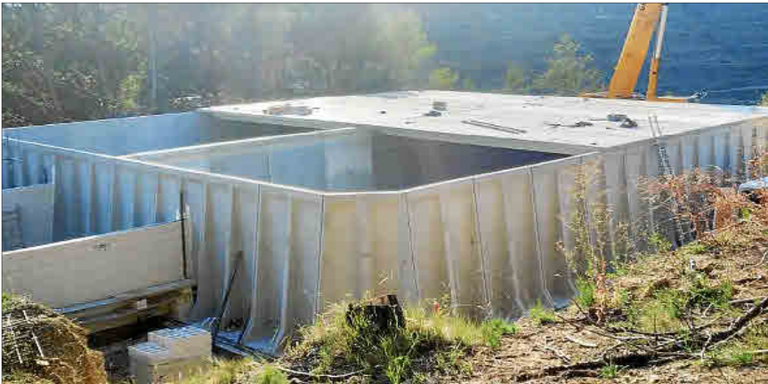
Así será el depósito que se prevé instalar en la calle Roca Llisa y que evitará las inundaciones.
